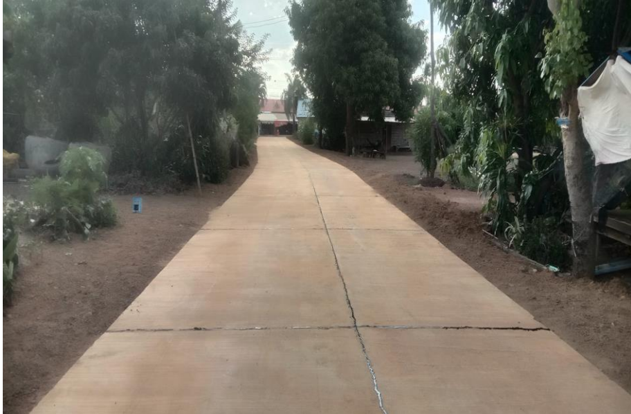
26.โครงการก่อสร้างถนนคอนกรีตเสริมเหล็ก ถนนโคกเจริญ-โนนศรีสุข หมู่ที่ 12 บ้านโคกเจริญ
