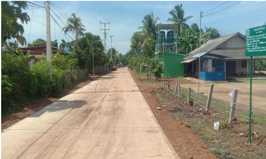
22.โครงการปรับปรุงถนนคอนกรีตเสริมเหล็ก สายกลางหมู่บ้าน หมู่ที่ 5 บ้านซับบอน
